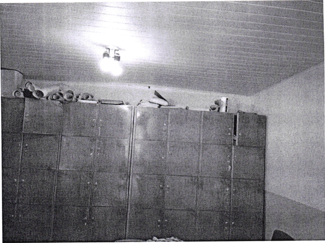
Arrumar o forro na sala dos professores
