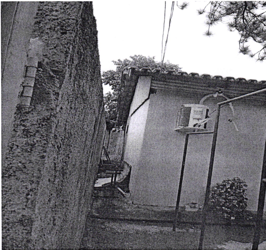
Chegar a parede no muro e arrumar a lateral
