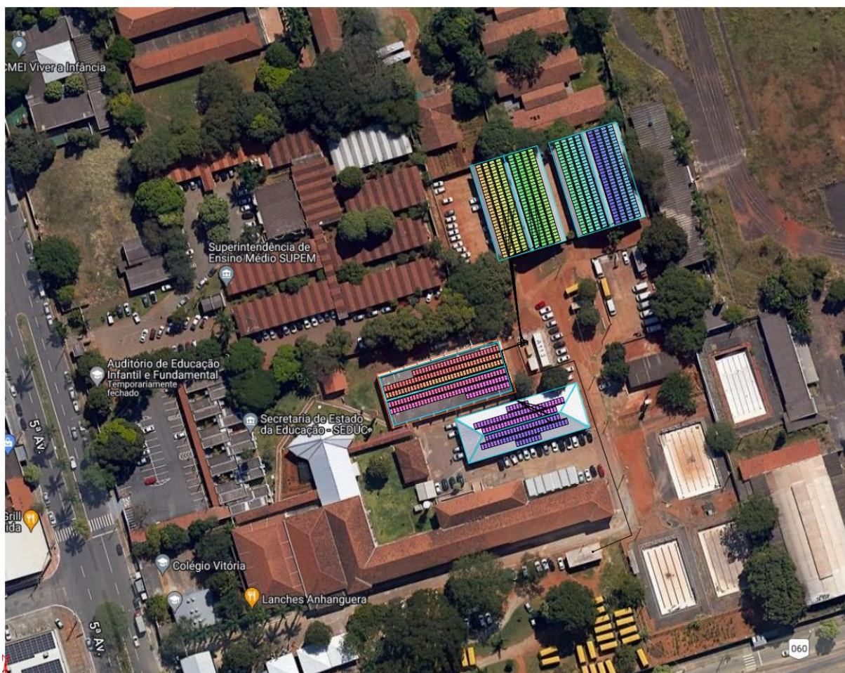
FIGURA 2 – ÁREA SUGERIDA PARA INSTALAÇÃO DO SISTEMA FV.
